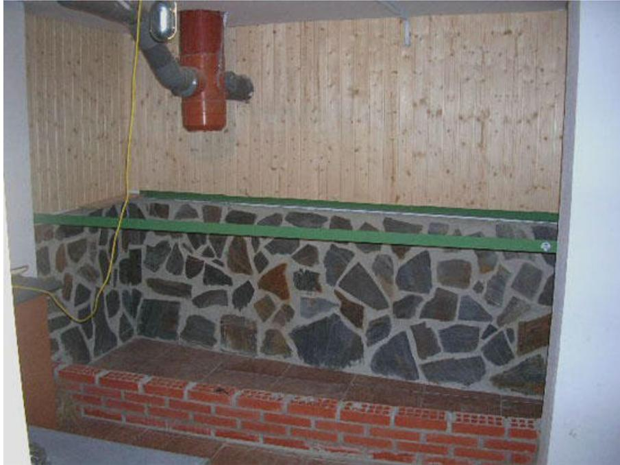
El tabique lateral, que une el muro de carga con uno de los pilares frontales, también es realizado con ladrillo visto. Este tabique tendrá la misma altura que el fondo de piezas de piedra para así poder colocar el techo del recinto sobre los ángulos de hierro.
