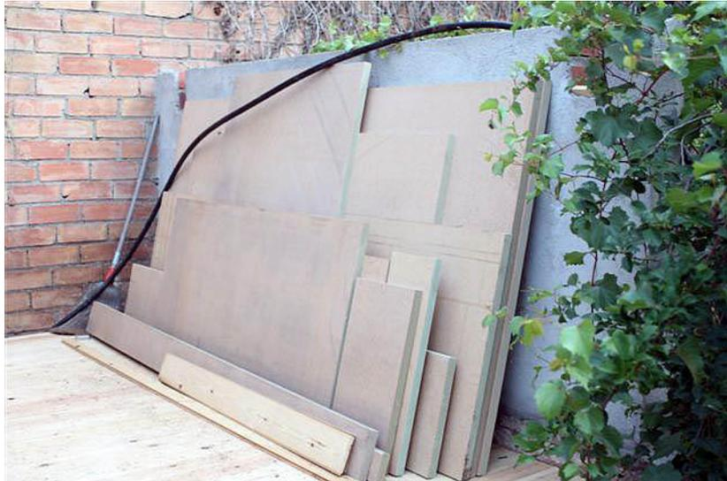
Nos ponemos al curro: se trata de forrar las paredes de obra con paneles de 35mm de DM, recortar los paneles para hacer los encajes de las viguetas de sujeción del techo y montar el techo de machihembrado, con cuidado de quedar enrasado con el techo de la caseta vieja, total para un chico de campo como yo pues un plis plas.....jejeje.
